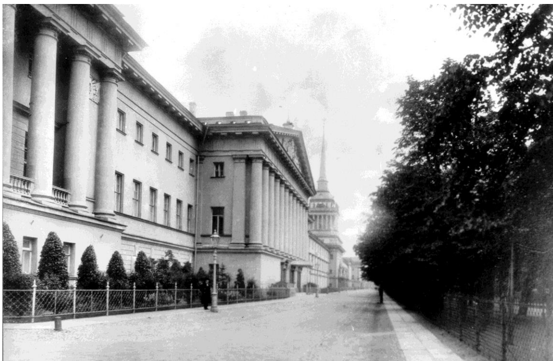
Здание Главного Адмиралтейства в Санкт-Петербурге
