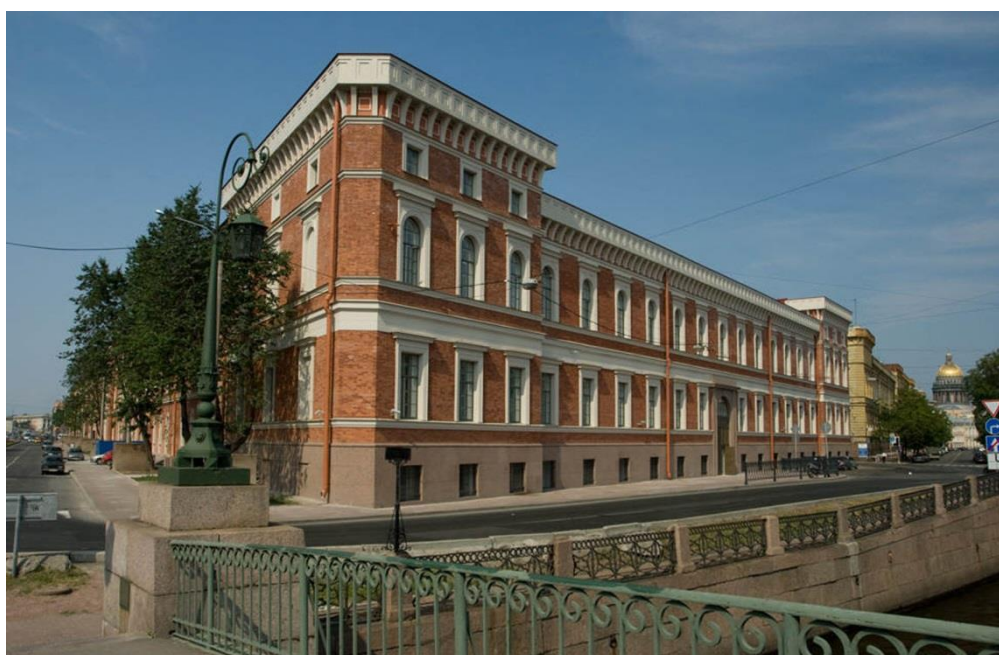
Здание Центрального военно-морского музея со стороны реки Мойки. 2012 г.
