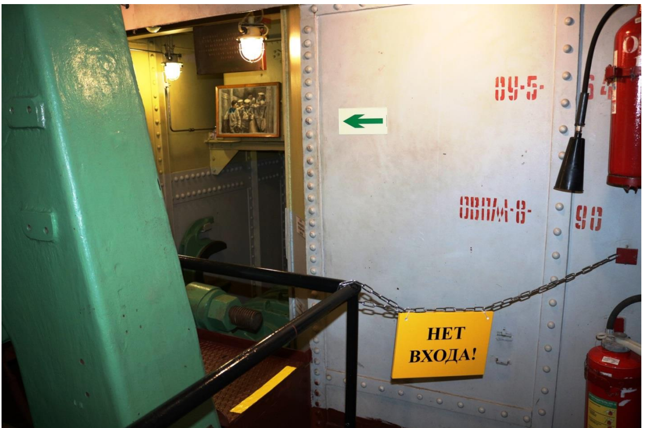
Историческое машинно-котельное отделение крейсера
