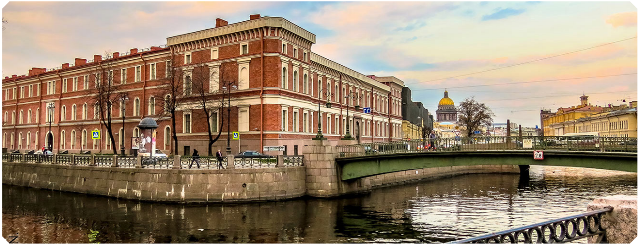
Современное здание ЦВММ
