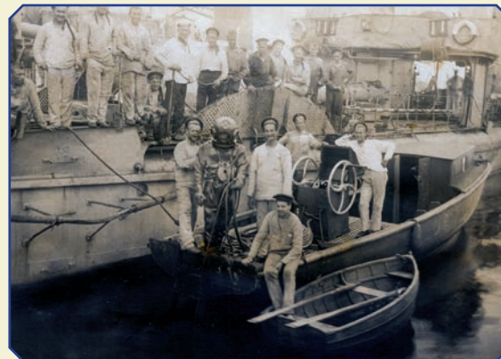
58. Осмотр водолазами подводных пробоин на эскадренном миноносце «АМУРЕЦ»
